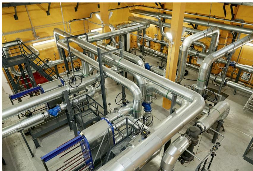
требление ЦТП на собственные нужды в 2 раза. Уменьшить теплопотери помогают современные пластинчатые теплообменники с высоким коэффициентом теплопередачи.
