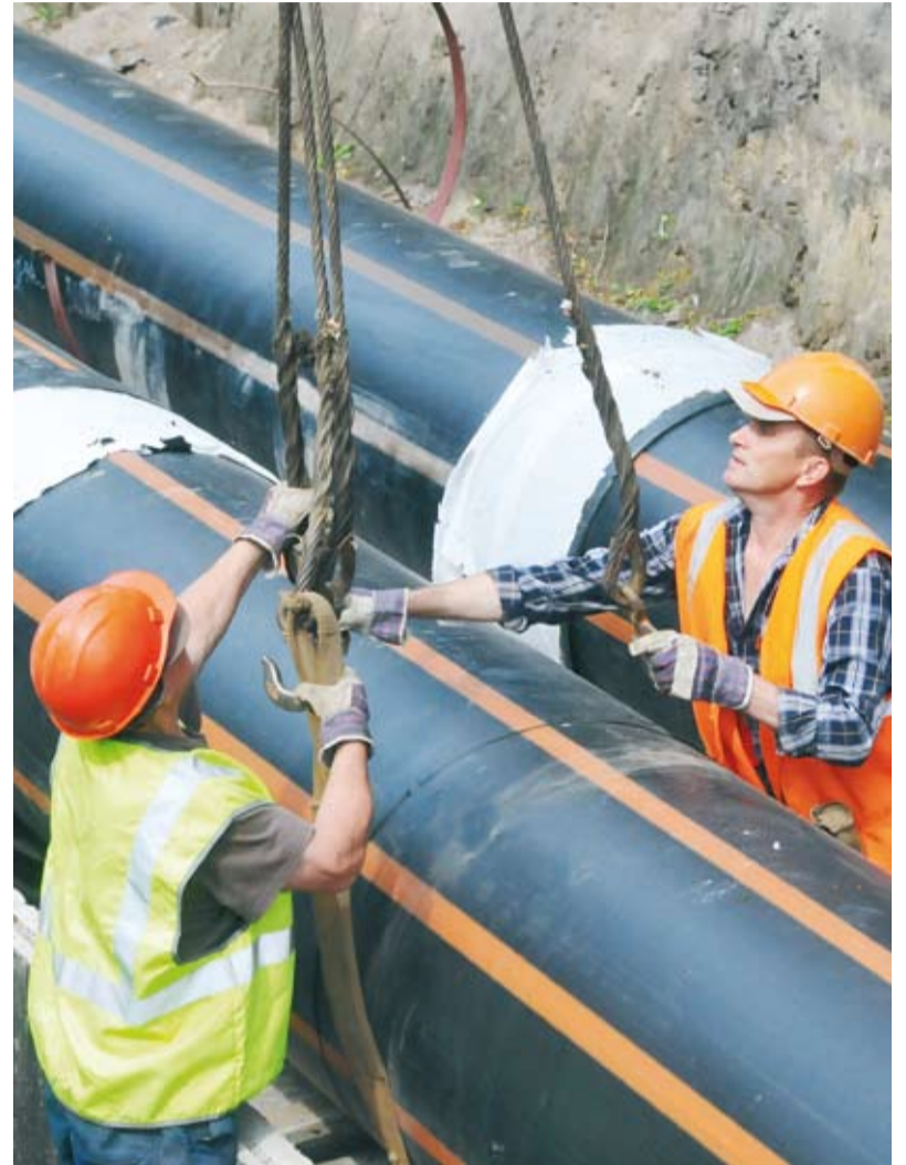
Порядок на стройплощадках должен поддерживаться постоянно
