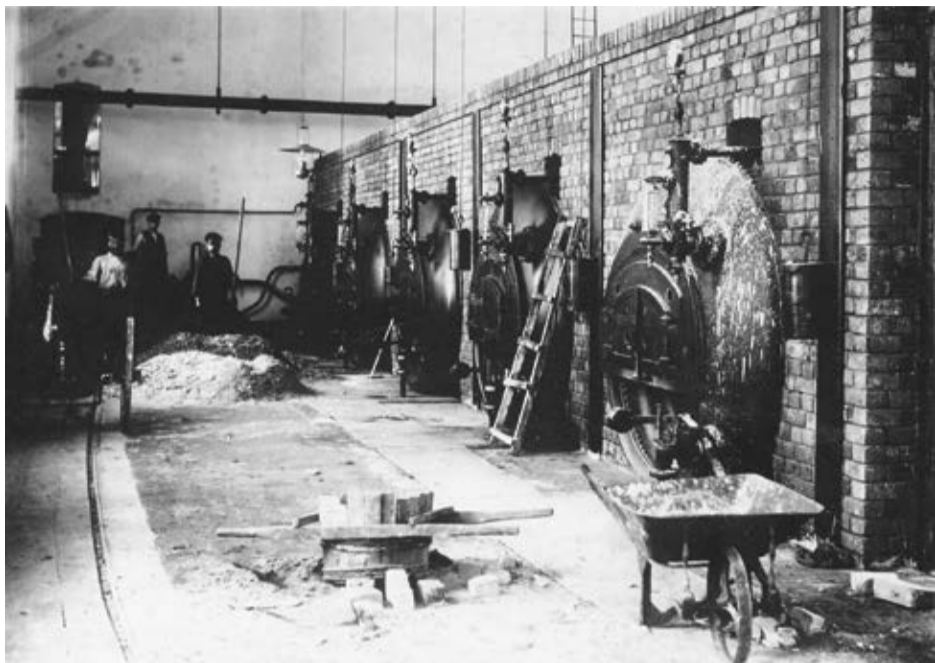
Внутренний вид котельной. 1901 год. Фото из архива ГУП «ТЭК СПб»
