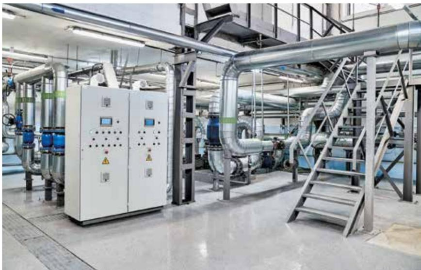
благодаря автоматике, которая задает и контролирует необходимые параметры оборудования, он работает без постоянного участия обслуживающего персонала. Еще один неизменный атрибут модернизированных ЦТП в зоне компании — это система погодозависимого регулирования. Работает это так: автоматика сверяется с температурой наружного воздуха и подогревает теплоноситель до необходимого градуса. Так в квартирах горожан обеспечивается
