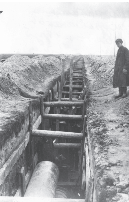
Испытание гидравлическим давлением труб. 1901 год
