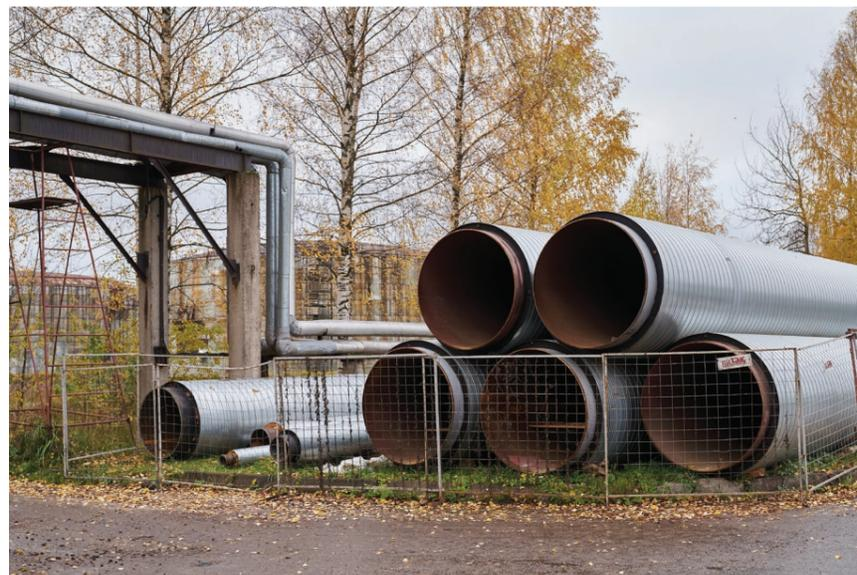
ментами и изношенной запорной арматурой. К настоящему времени уже смонтирована временная теплосеть длиной 419 метров с установкой узлов учета. Завершено строительство временного 94-метрового паропровода. Благодаря «дублерам» теплоснабжение всего массива зданий на период реконструкции будет стабильным и надежным.
