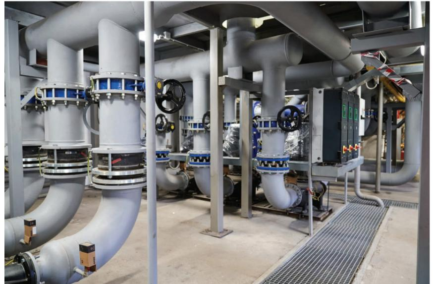
регулирования позволит устанавливать температуру теплоносителя в соответствии с температурой наружного воздуха — участия персонала для этого не потребуется.
