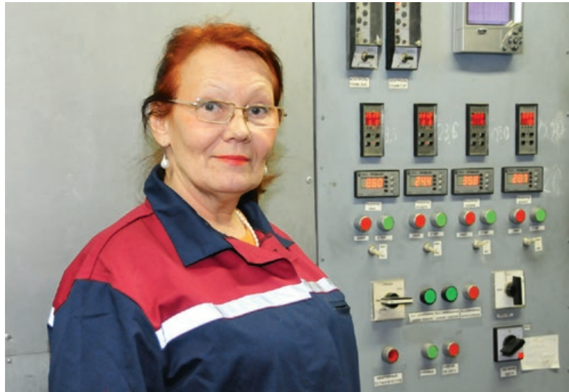
Наталья Шилова, оператор котельной на Софийской, 54
